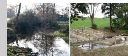
*La Petite Boulogne avant et après travaux. L'aménagement réalisé permet un abreuvement et un passage respectueux du cours d'eau.*
