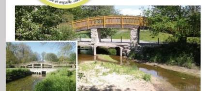
*Passage à gué de la Blanche du Gravier sur La Vie, avant et après travaux. Les multiples bûches ont été remplacées par deux ponts-cadres.*
