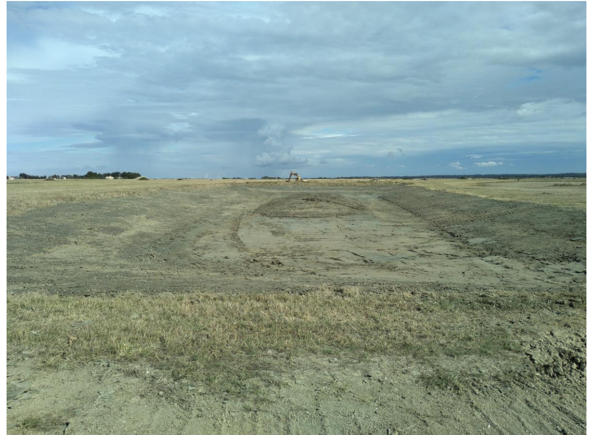
Pendant les travaux
