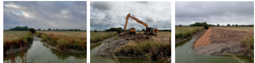
Travaux d'adoucissement de berges
