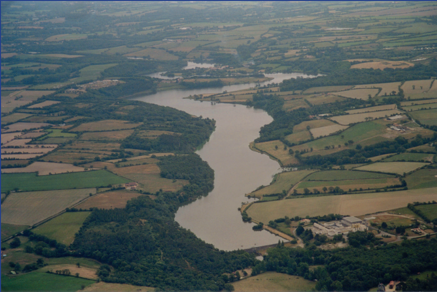
Barrage du Jaunay
