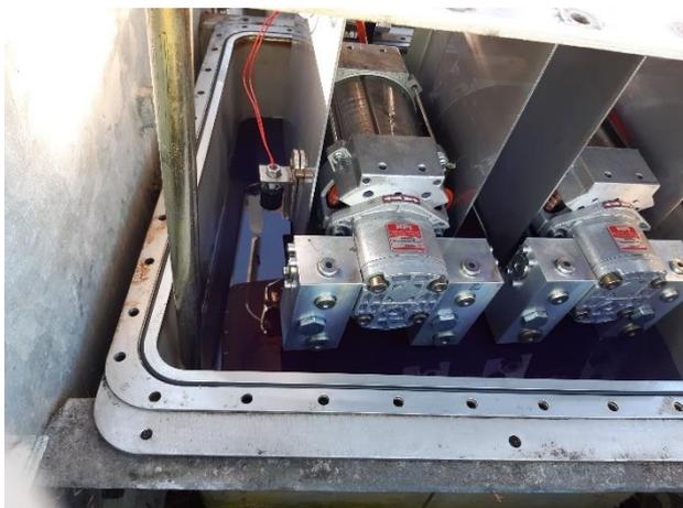
*Barrage des Vallées – Vidange et remplacement des filtres des centrales hydrauliques*
