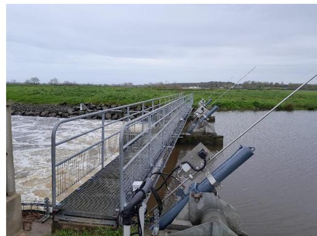
*Clapet de la Pinsonnière – Réfection des tiges de vérins*
