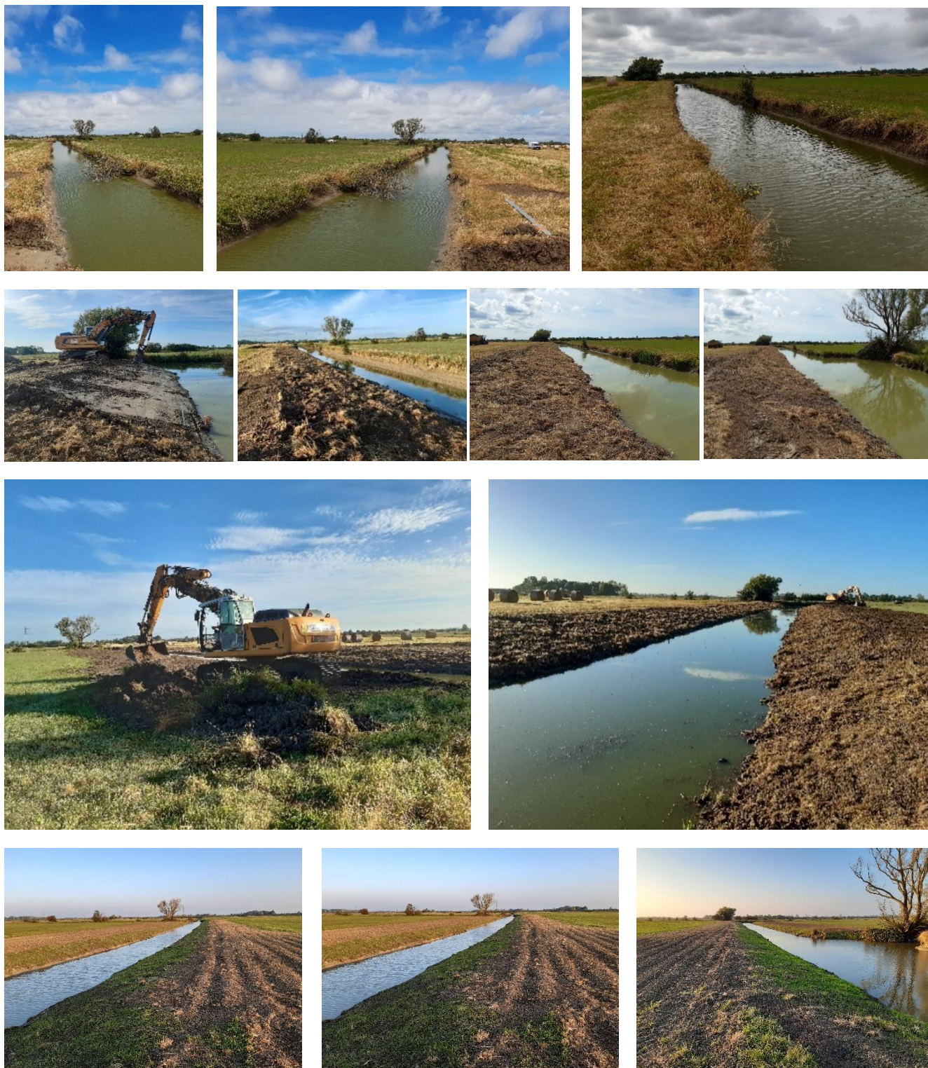
Adoucissement de berges - Site du Guittard à Saint-Hilaire-de-Riez - Année 2024
