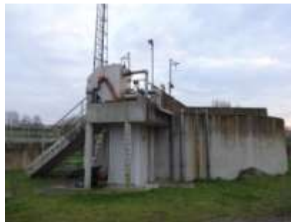
Action de la commune de la Genétouze : une partie des eaux usées traitées est pompée et renvoyée en tête de station pour le lavage du tamiseur.
